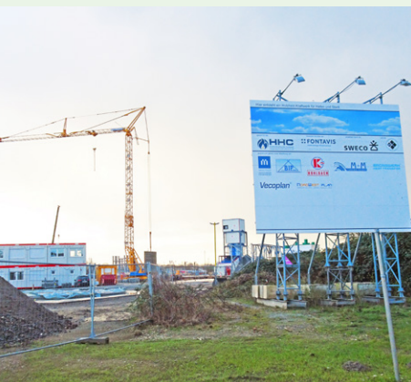
Baustellenfoto aus dem Januar dieses Jahres
