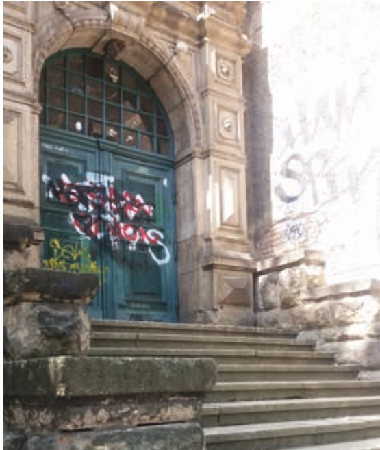
Das nennt man „nicht einladende Infrastruktur“, gesehen am Max-Delbrück-Gymnasium in Berlin-Niederschönhausen
